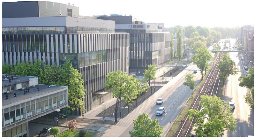
Maraton – najnowszy budynek biurowy firmy SKANSKA zlokalizowany w Poznaniu. Fot. archiwum firmy
